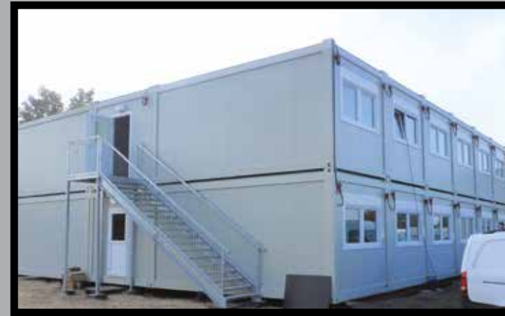
Logement pour réfugiés - Allemagne Refugee accomodations - Germany
